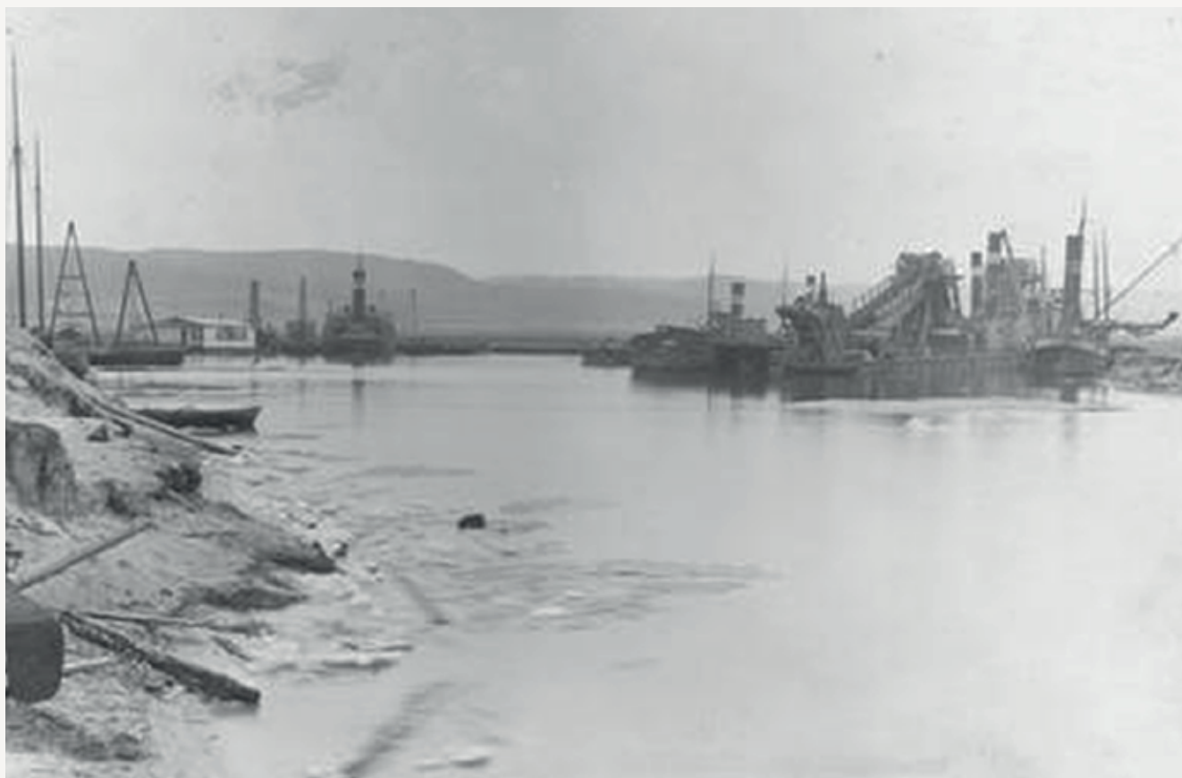
Budowa portu morskiego w Gdyni, 1926. Fot. Narodowe Archiwum Cyfrowe
